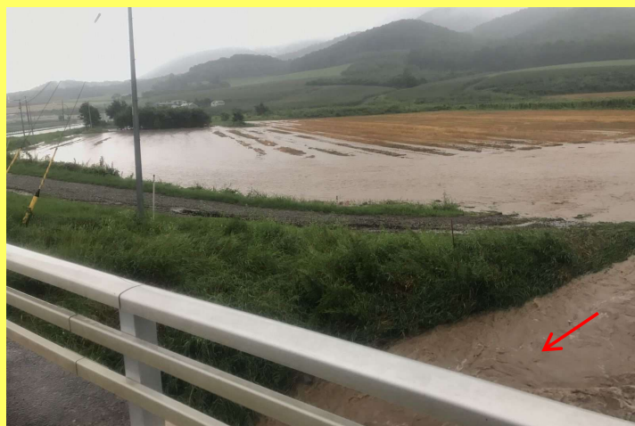
パンケビバウシ川氾濫状況（大曲橋上流） <令和5年8月>
