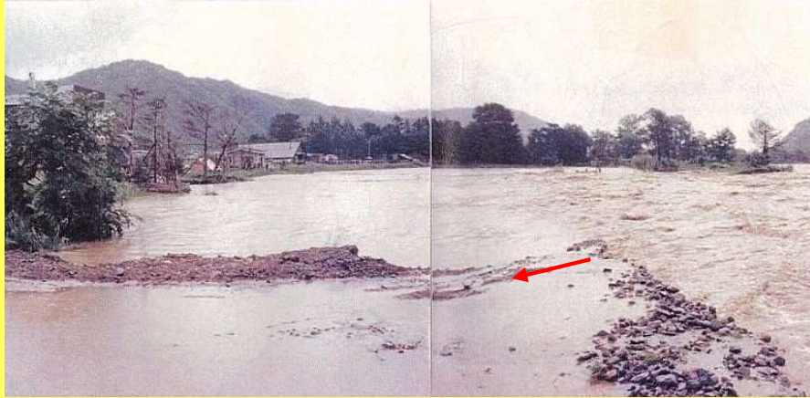
無加川 氾濫状況（八千代橋上流） ＜昭和50年8月＞
