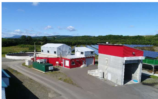
興部北興バイオガスプラント
