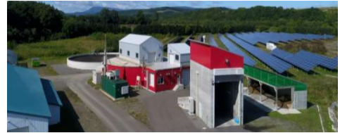
興部北興バイオガスプラント
