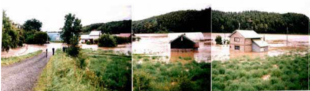
平成4年9月の豪雨による羅崩地区の浸水状況(斜里川)
