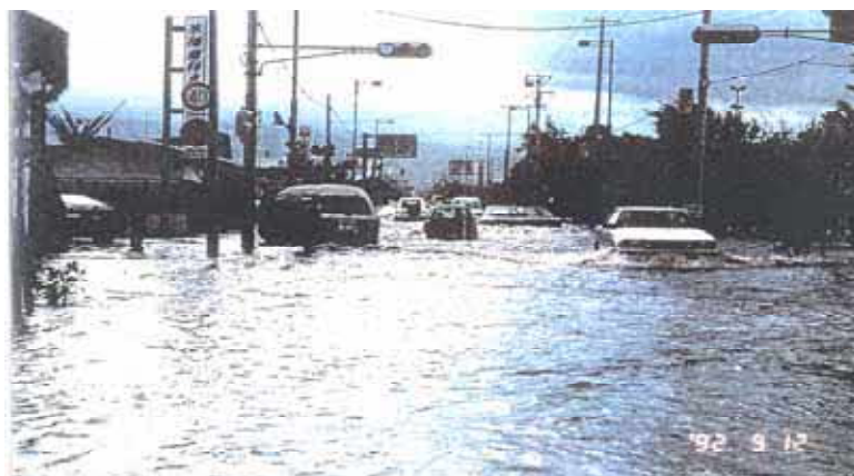
平成4年9月の豪雨による斜里市街地の浸水状況
