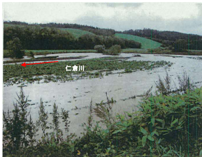
第 5 号橋上流の浸水状況（平成 18 年 10 月撮影）
