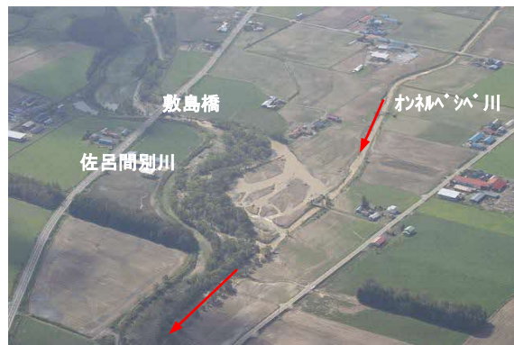
敷島橋下流の浸水状況
