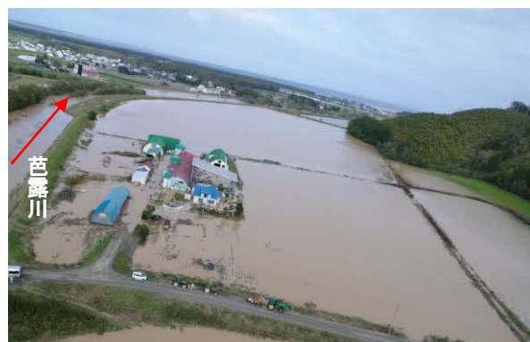
4 号橋下流右岸側の浸水状況 (平成 18 年 10 月撮影)
