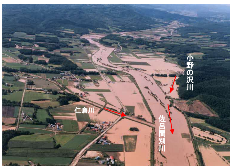
小野の沢川、佐呂間別川合流点付近の浸水状況（平成18年10月撮影）
