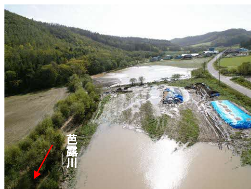
新佐々木橋上流の浸水状況 (平成 18 年 10 月撮影)
