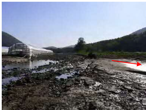
平成18年10月の被災状況（新国地先）
