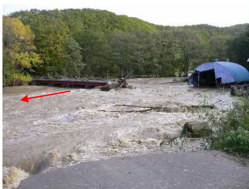
平成18年10月の被災状況（馬産橋）
